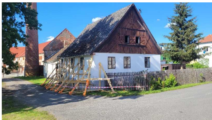
Probíhající opravy kulturní památky – Braunova mlýna
