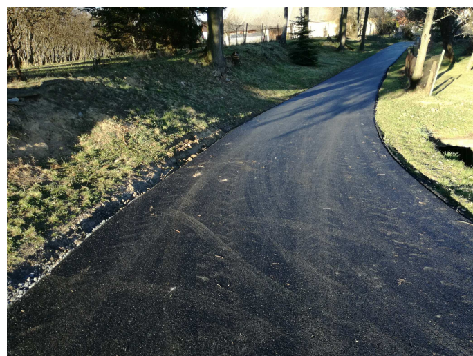
Čerstvě položený asfalt ve Spůli
